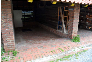
WC im Außenbereich
