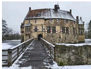
Weg zur Hauptburg mit Zugangskontrolle
